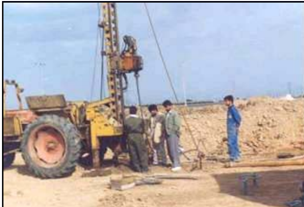
سیستم جک هیدرولیکی جهت بالا بردن و سقوط وزنه
